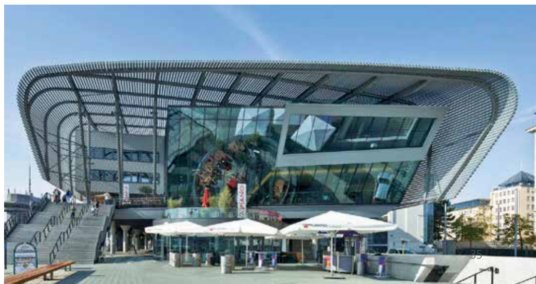
Central bus station, Munich, Germany Photo: HOCHTIEF Projektentwicklung GmbH
